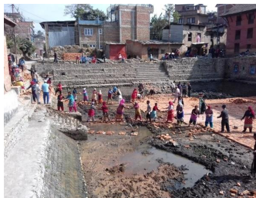
水源池の改修作業の様子(国連ハビタット提供)
