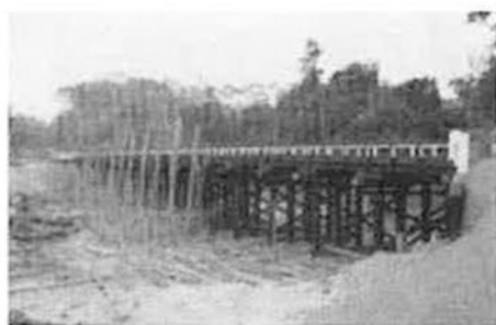
クシュー橋架設工事（1963年 昭和38年）
